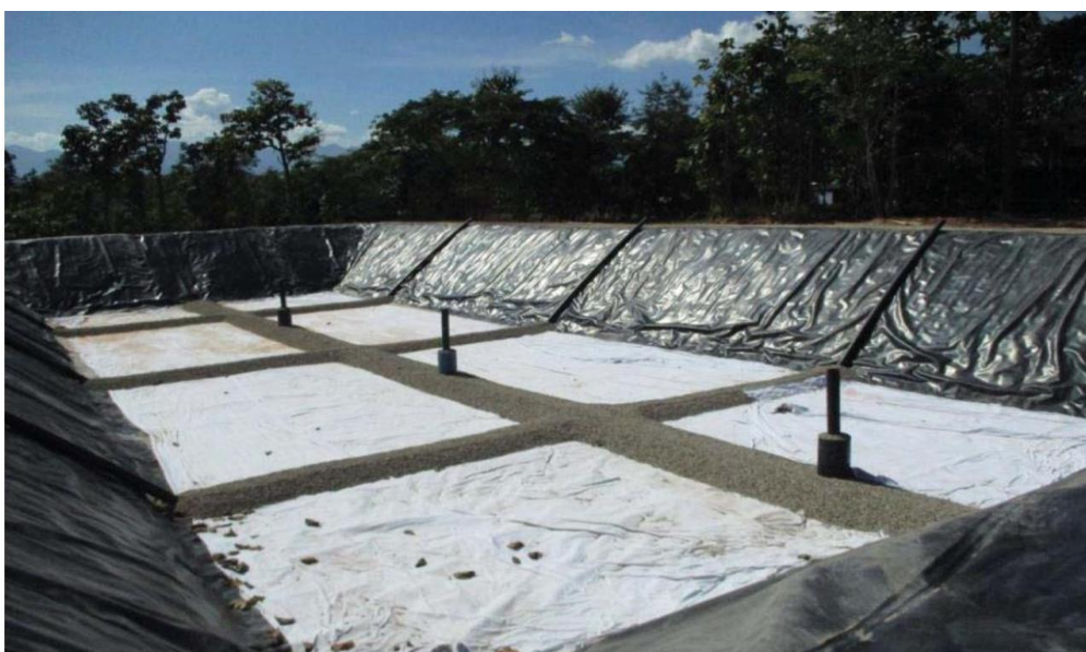
รูปที่ ๑๔ บ่อฝังกลบขยะมูลฝอยแบบกึ่งใช้อากาศในพื้นที่องค์การบริหารส่วนตำบลแม่หละ
