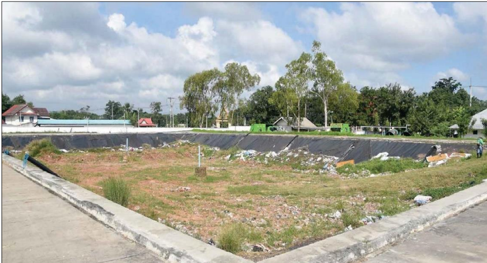
รูปที่ ๑๗ บ่อฝังกลบขยะแบบกึ่งใช้อากาศของเทศบาลเมืองสีคิ้ว
